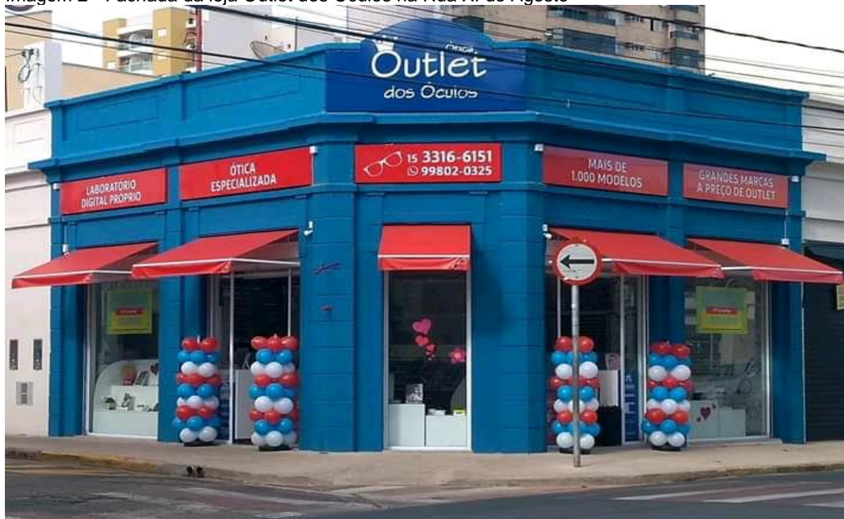
Imagem 2 - Fachada da loja Outlet dos Óculos na Rua XI de Agosto
